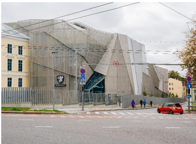
Kaitsepolitsei ameti hoonetekompleks (teostaja: Nordecon AS, foto: Tõnu Tunnel)
