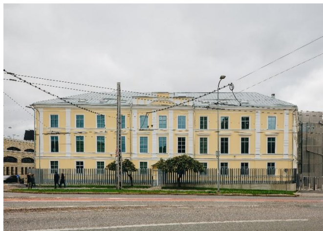
Kaitsepolitsei ameti hoonetekompleks (teostaja: Nordecon AS, foto: Tõnu Tunnel)
