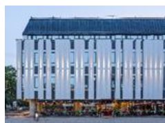
Office building Palangos str. 4/ Vilniaus str. 33 Vilnius
