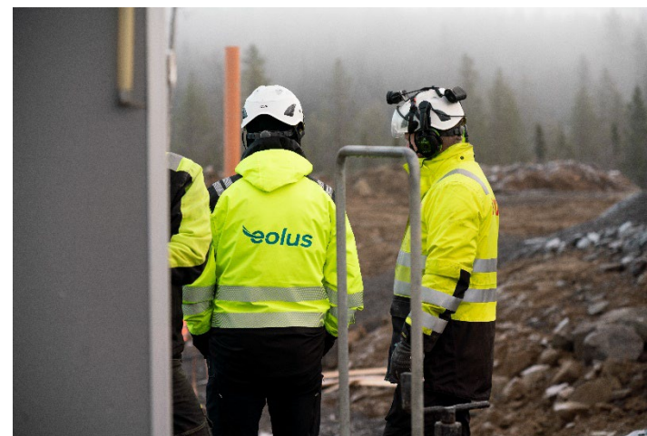
Gjutning av fundament för projekt Rosenskog, hösten 2022
