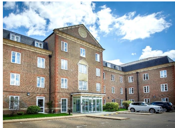
Rosewood House à Londres (UK)
