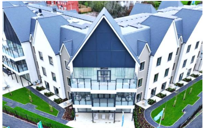
Dawlish à Dawlish (UK) Maison de repos achevée en février 2024
