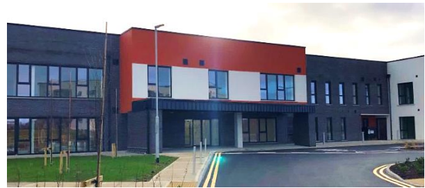
Dundalk Nursing Home à Dundalk (IE) Maison de repos acquise en avril 2022
