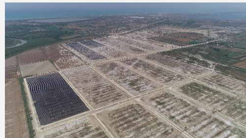
Karavasta construction site
