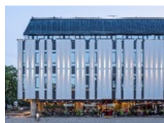
Office building Palangos str. 4/ Vilniaus str. 33 Vilnius
