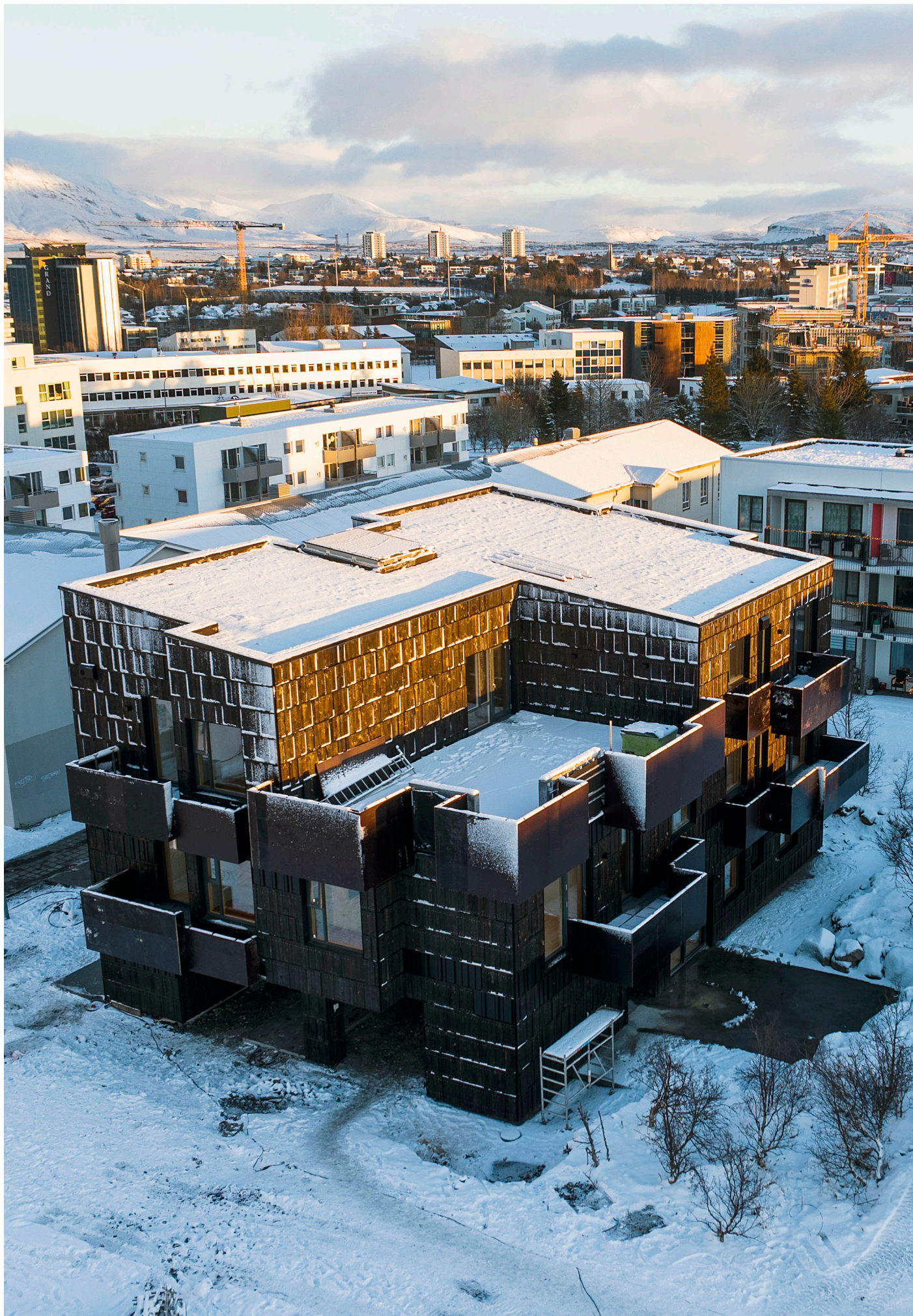
Háteigsvegur 59. Mynd: Róbert Reynisson.
