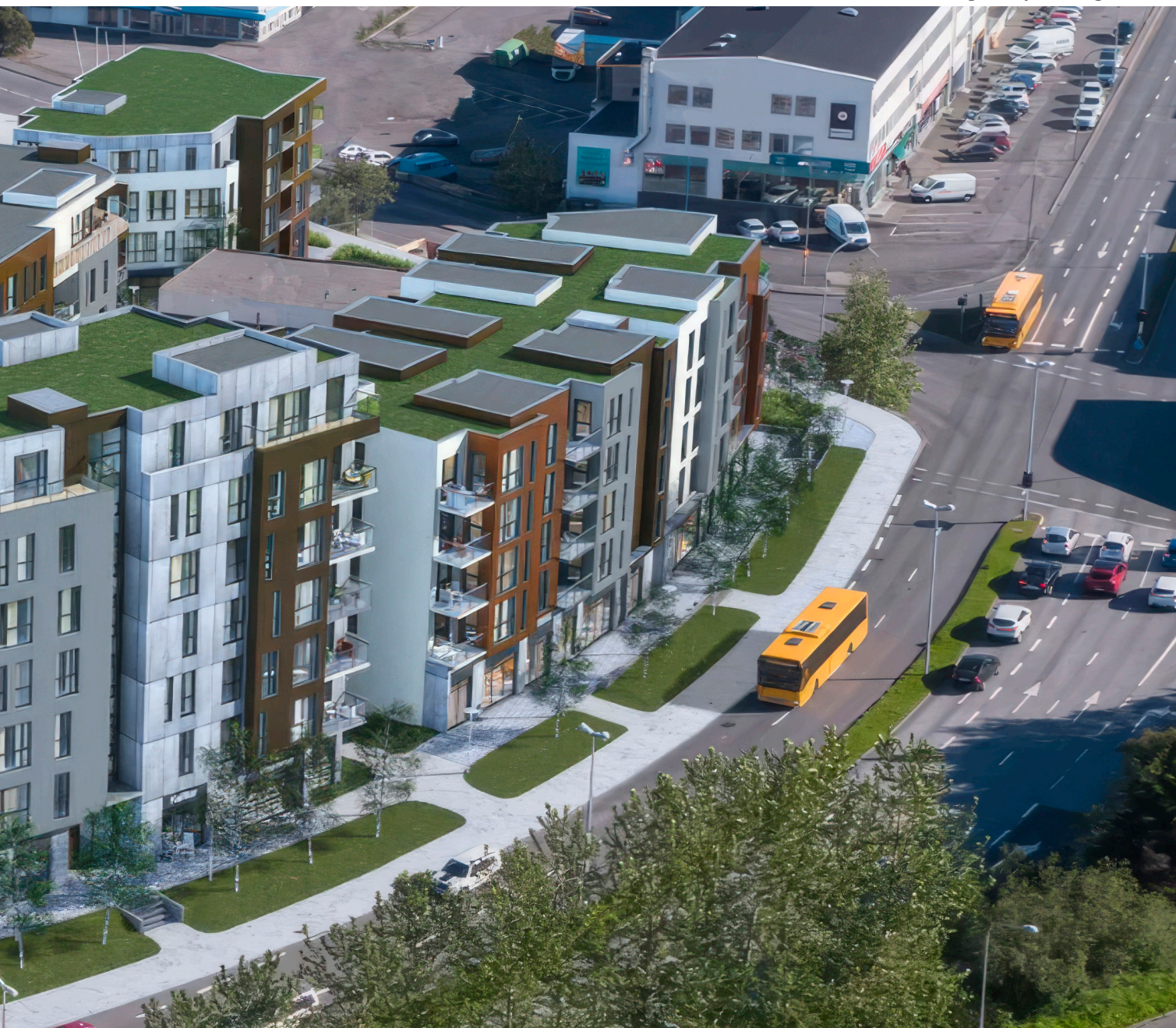
Grensásvegur 1. Mynd: Félagsbústaðir.
