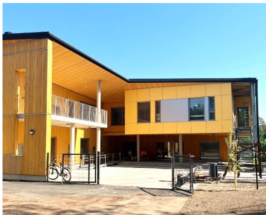
Espoo Kuurinkallio in Espoo (FI) Service community opgeleverd in mei 2024
