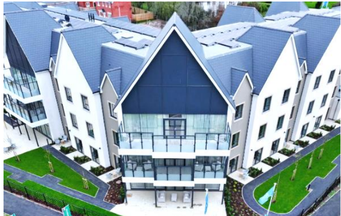
Dawlish in Dawlish (UK) Woonzorgcentrum voltooid in februari 2024
