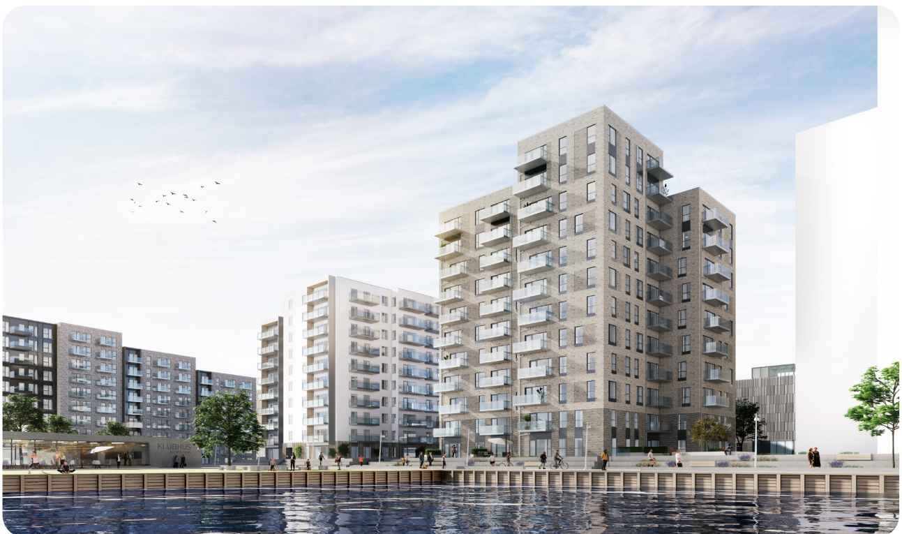
Havnehus 2, Østre Havn, Aalborg 5.675 m 2 udlejningsboliger under opførelse til privat investor.
