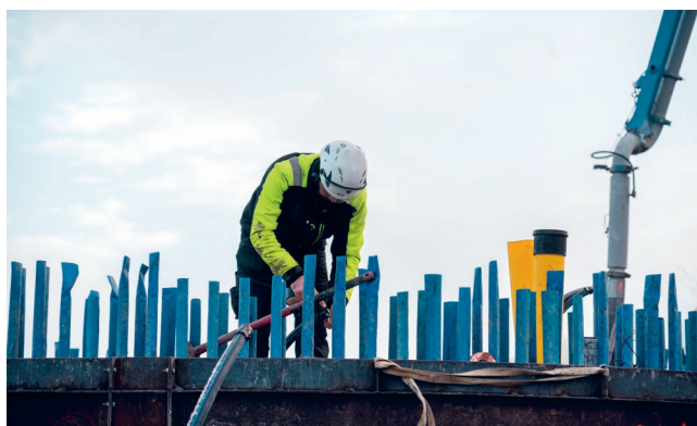
Under hösten pågick ett intensivt arbete med fundamenten i Tjärnäs.
