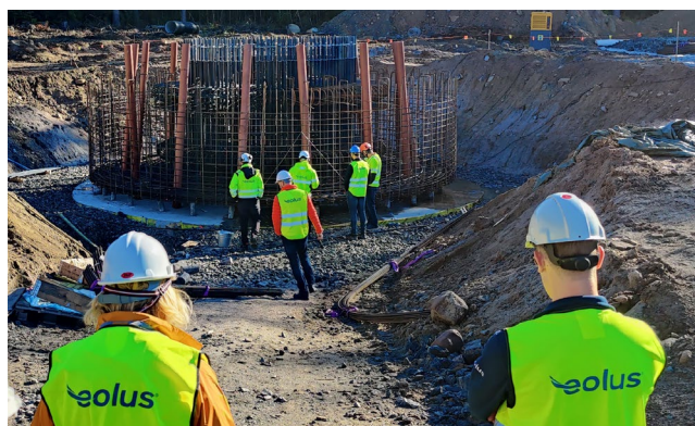
Gjutningen av fundamenten i projekt Rosenskog genomfördes under hösten 2022.
