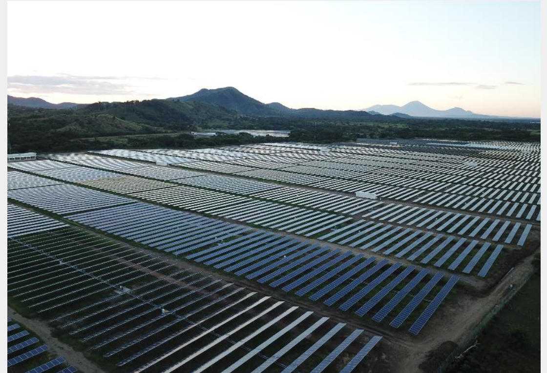
The 35 MW Los Prados plant in Honduras.
