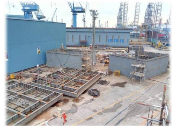
Utilities module fabrication
