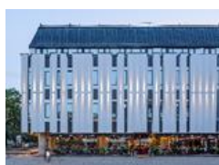
Office building Palangos str. 4/ Vilniaus str. 33 Vilnius
