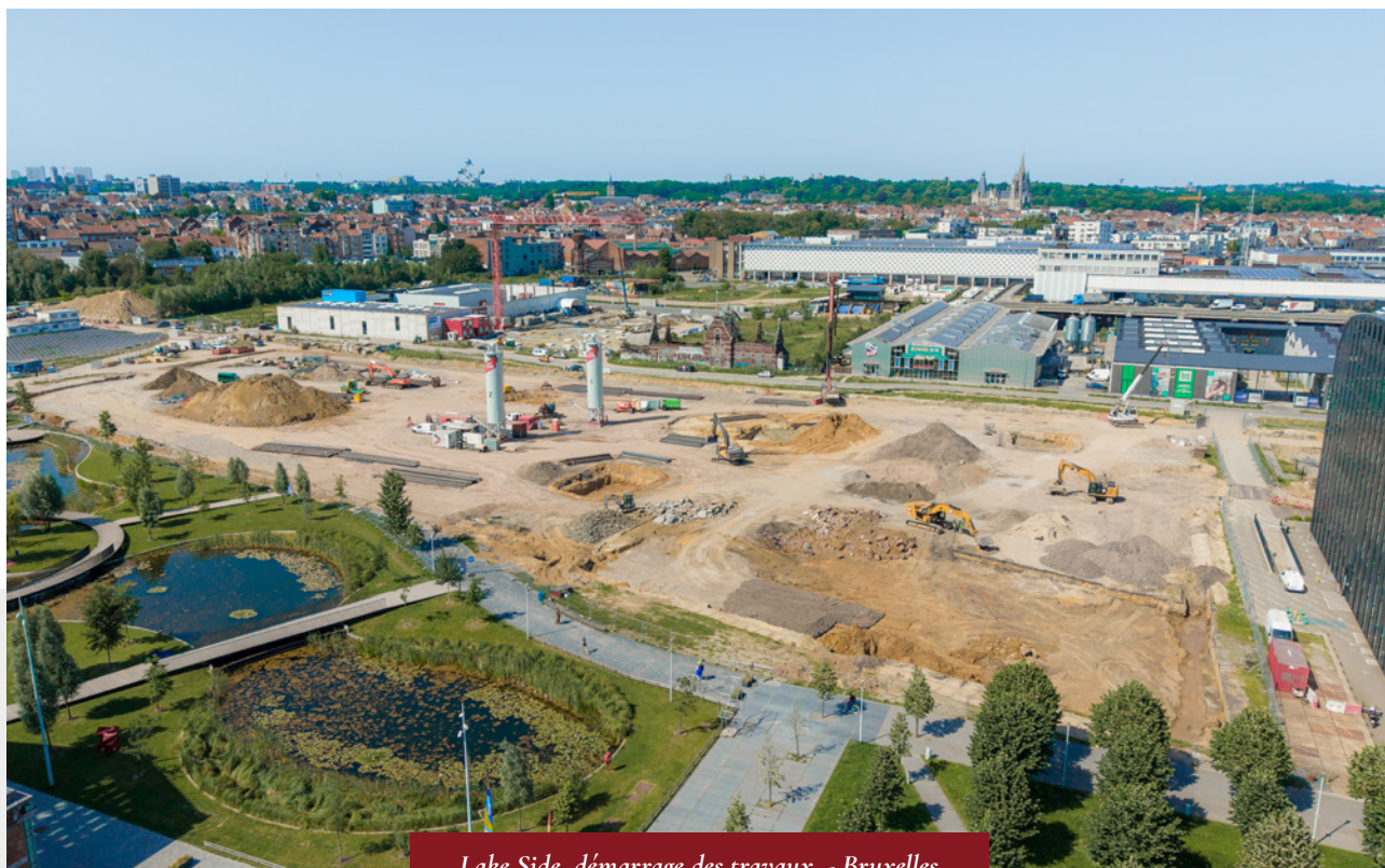
Lake Side, démarrage des travaux - Bruxelles
