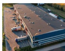
„Dommo business park“ Riga Latvia
