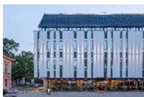
Office building Palangos str. 4/ Vilniaus str. 33 Vilnius
