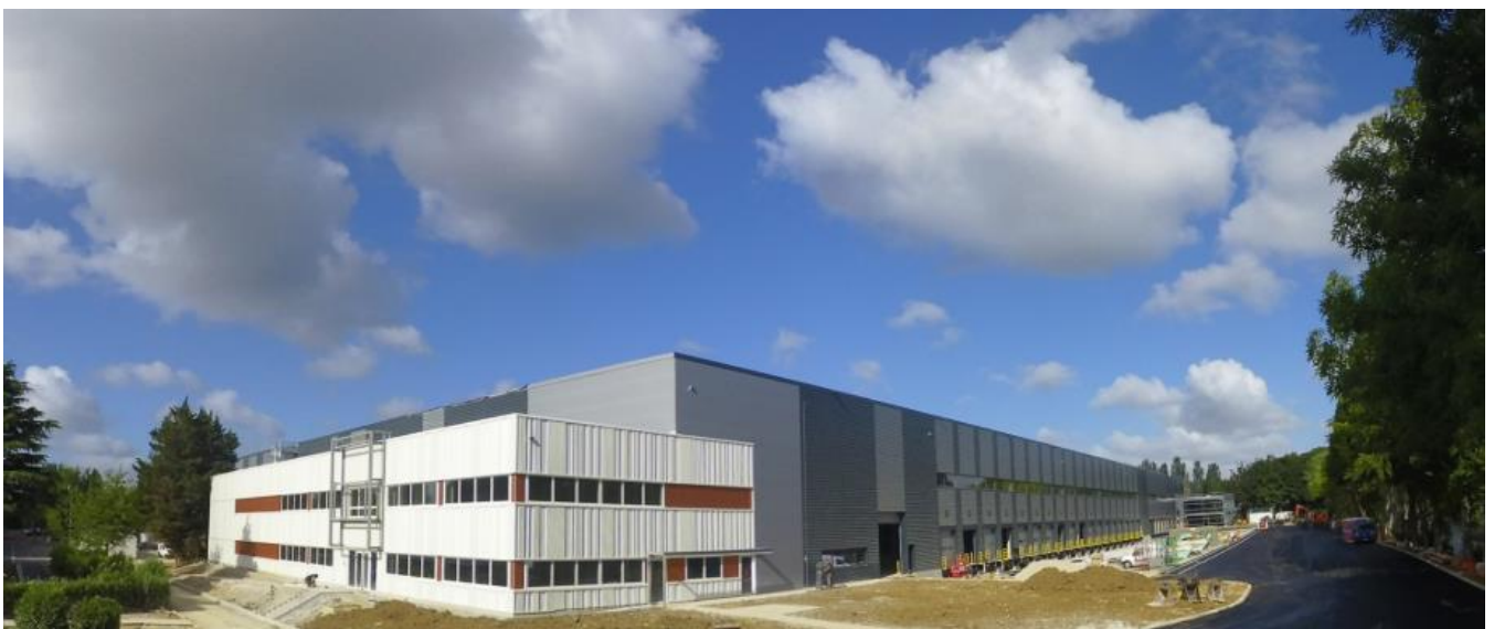
Juillet 2020 - Chantier de construction de la première cellule Carbone Neutre ARGAN
