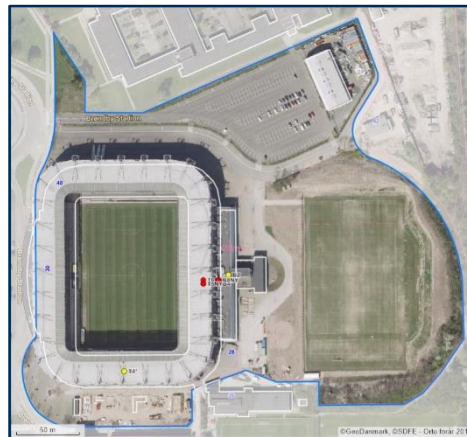
Oversigt over Brøndby IF (Forår 2018). Kilde: BBR
