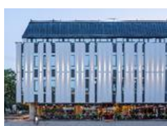
Office building Palangos str. 4/ Vilniaus str. 33 Vilnius
