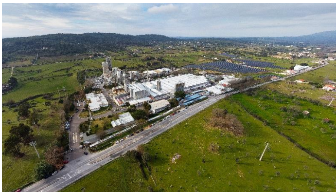
Abbildung 3: Luftaufnahme der Selenis-Industrieanlage in Portalegre, Portugal
