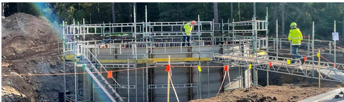
Under hösten färdigställs fundamenten för vindkraftverken i projekt Rosenskog utanför Falköping.
