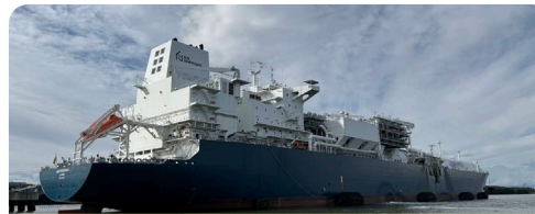
Klaipėda LNG terminal Lithuania 2014
