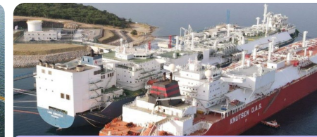
Krk LNG terminal Croatia 2016-2018
