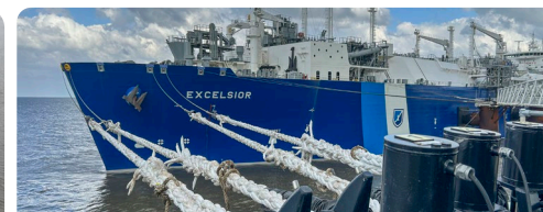
Wilhelmshaven 2 LNG terminal Germany 2024
