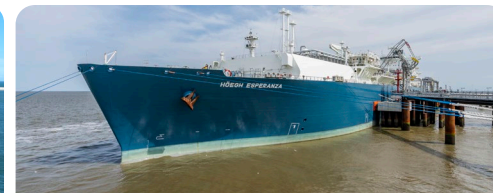
Wilhelmshaven 1 LNG terminal Germany 2022
