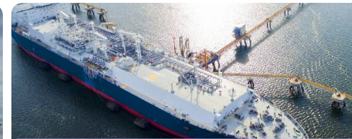
Cartagena LNG terminal Colombia 2015-2016
