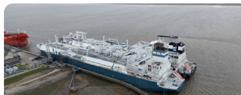
Brunsbüttel LNG terminal Germany 2023
