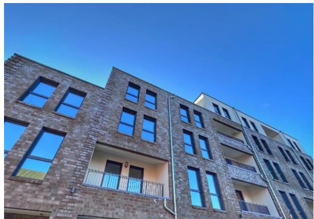
Quartier am Rathausmarkt à Bremervörde (DE) Campus de soins achevée en décembre 2022
