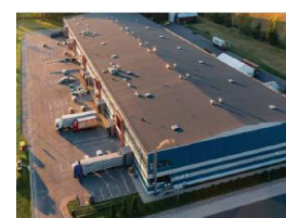
„Dommo business park“ Riga Latvia
