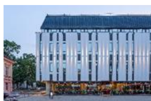
Office building Palangos str. 4/ Vilniaus str. 33 Vilnius
