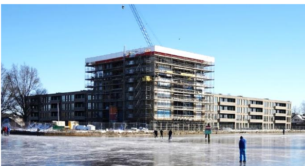
Nieuw Heerenhage in Heerenveen (NL) Ontwikkelingsproject in aanbouw
