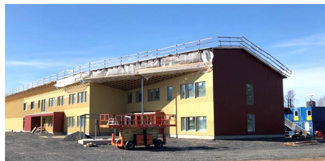
Kinderdagverblijf in Oulu (FI) Ontwikkelingsproject in aanbouw
