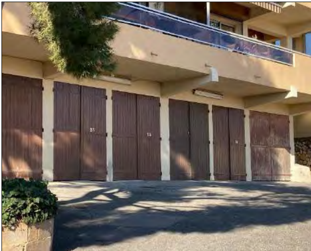
Vue sur les garages
