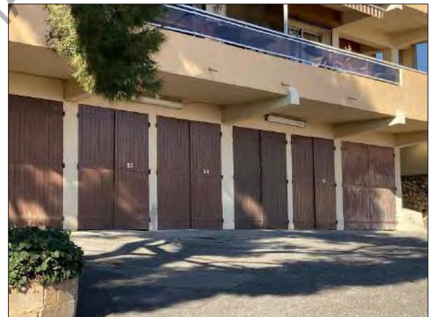
Vue sur les garages
