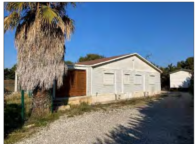
Partie Sud encombrée d'une construction modulaire
