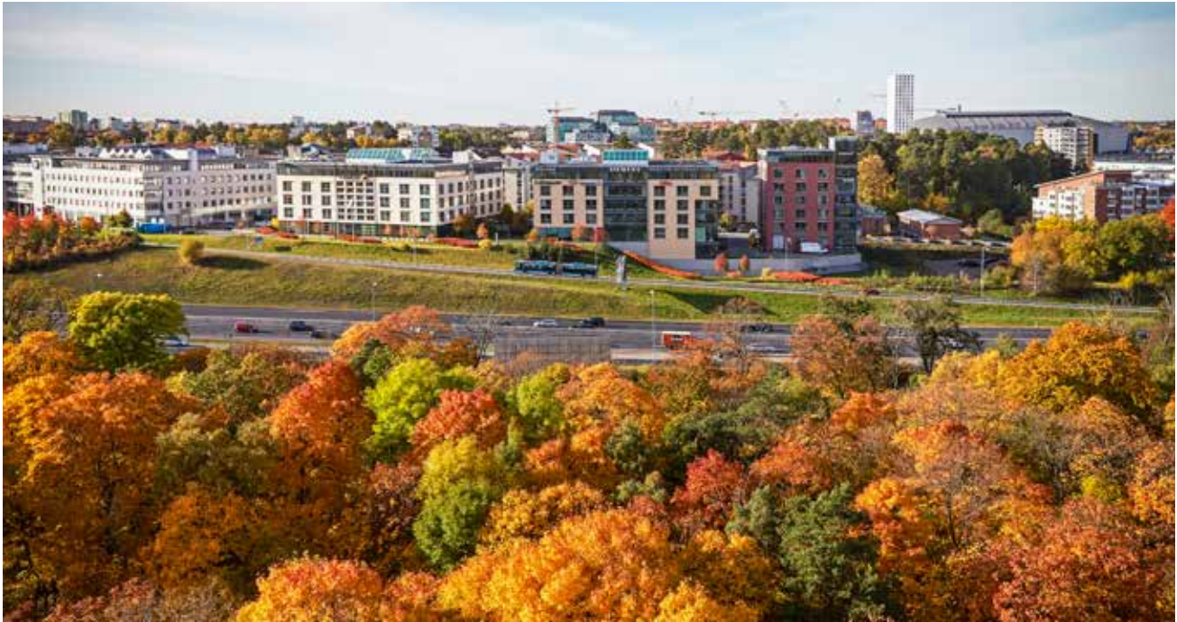
Fastigheten Hilton 3 i Solna är miljöcertifierad enligt BREEAM betyg Very Good.
