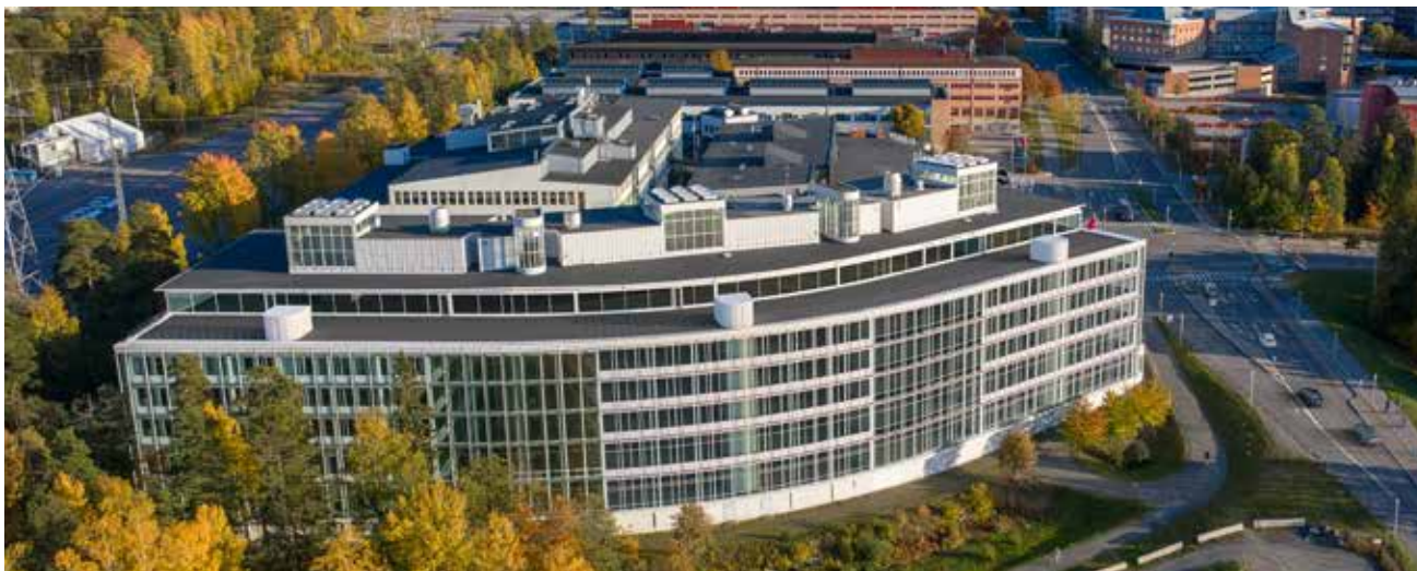
Kista Gate i höstskrud med delar av Klöverns fastighetsbestånd i Kista i bakgrunden.
