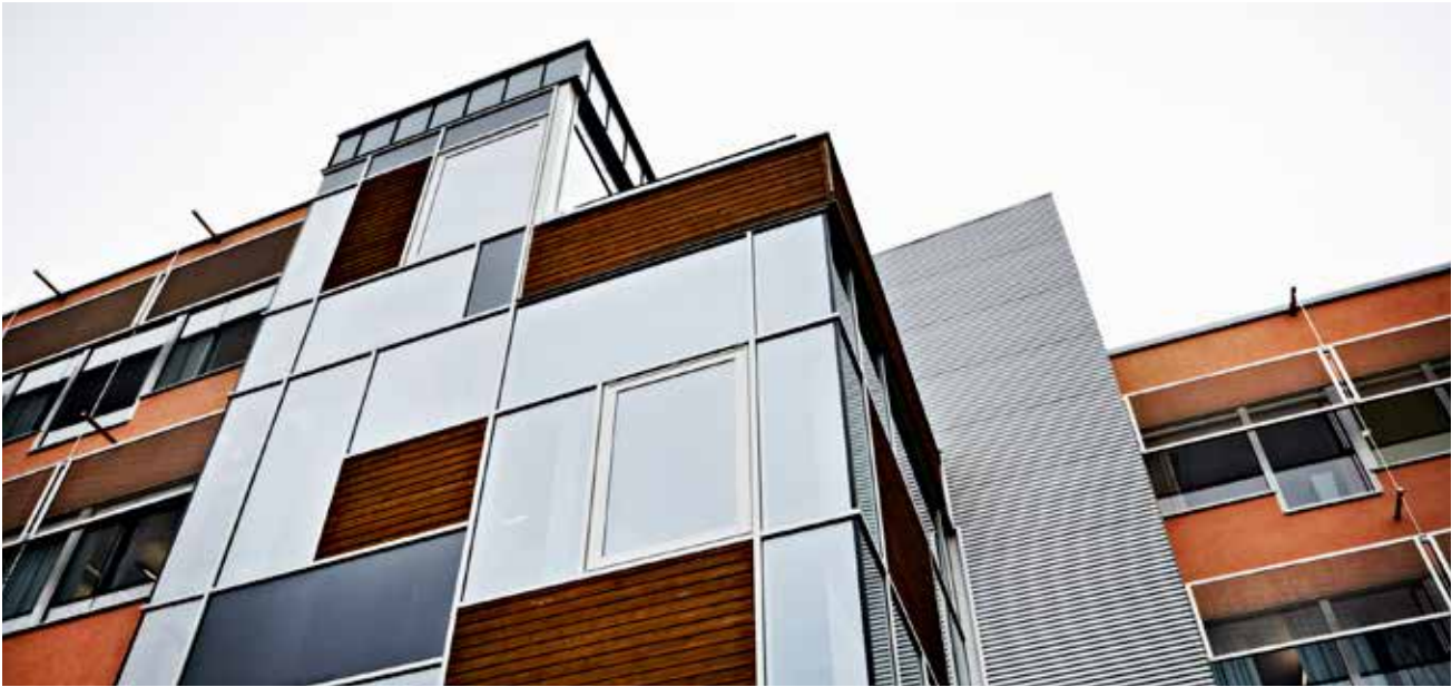
Fastigheten Glasblåsaren 7 i Linköping.
