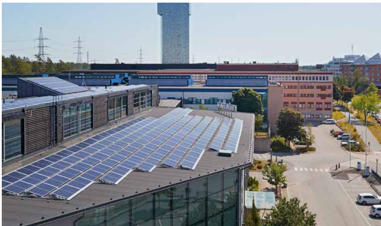
Solceller på taket på Kista Gate, Stockholm.
