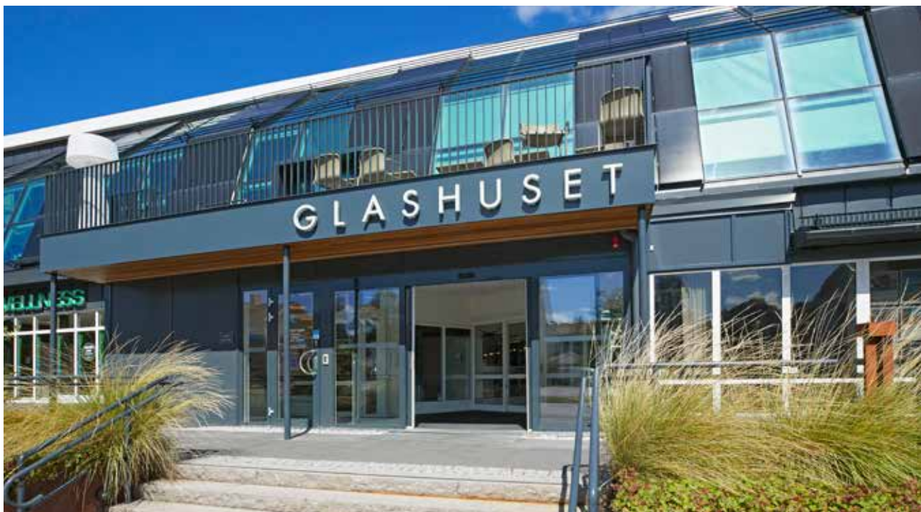
Glashuset i Göteborg med fastighetsbeteckningen Ugglum 1:76.
