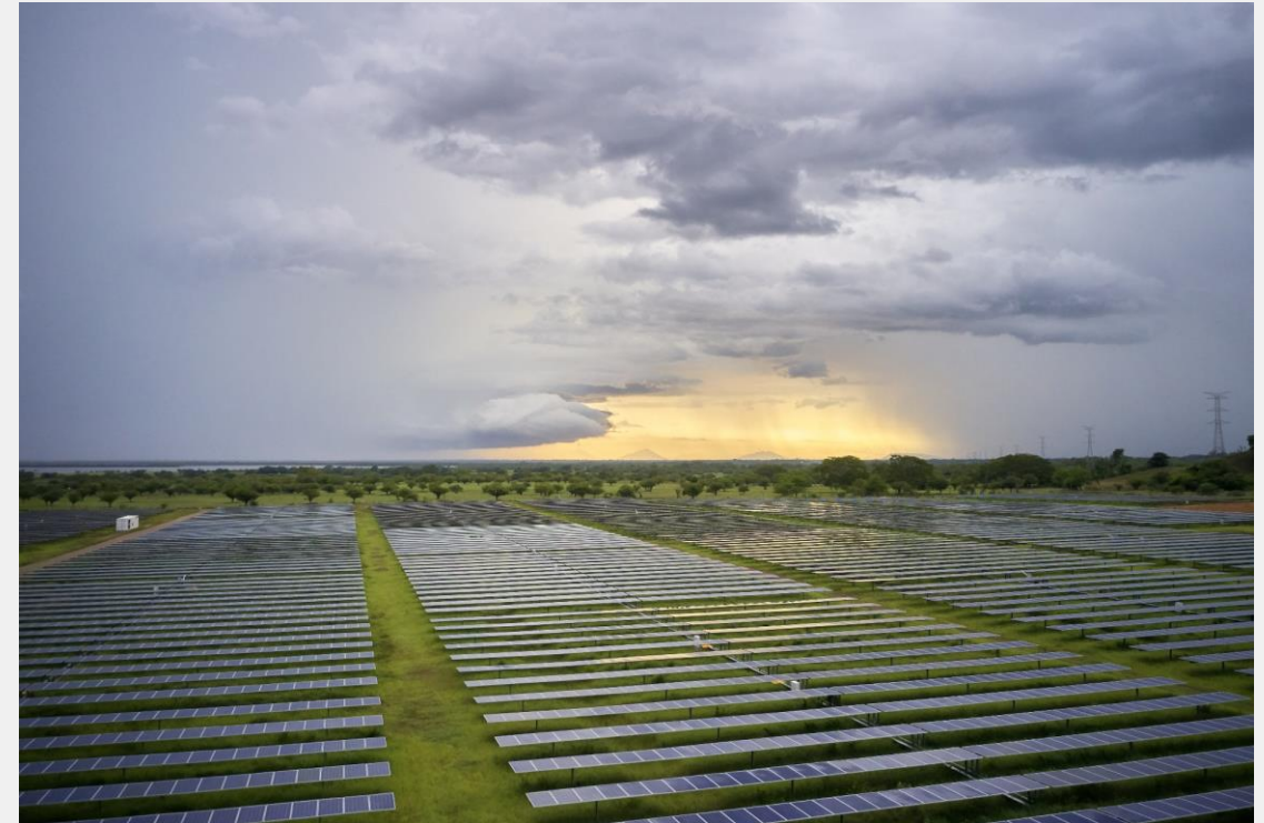
The 35 MW Los Prados plant, Honduras.
